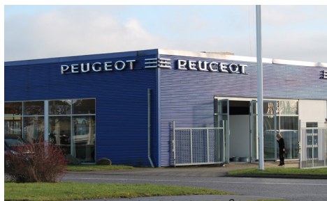
Fin tilpasset facadeskiltning på større virksomhed placeret på en hjørnegrund.
