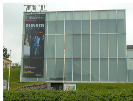
Midlertidig ophængning af bannere tillades i afgrænsede perioder. Banneret er så vidt muligt tilpasset facaden.
